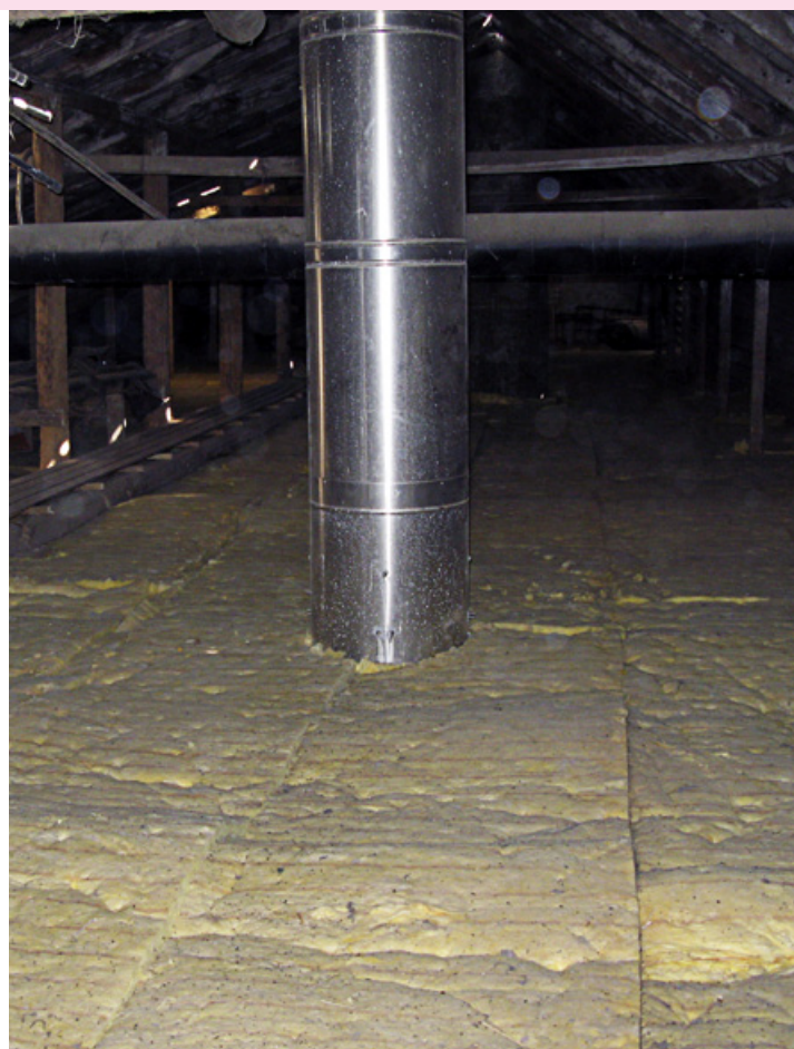
LOFTET OVER POLTESTALDEN ER ISOLERET, OG DET HAR GIVET MÆRKBARE KLIMAMÆSSIGE FORBEDRINGER I STALDEN, SOM ER INDRETTET I EN ÆLDRE BYGNING.
